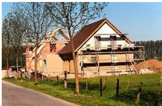
Neubaumaßnahme in Kleve-Düffelward
